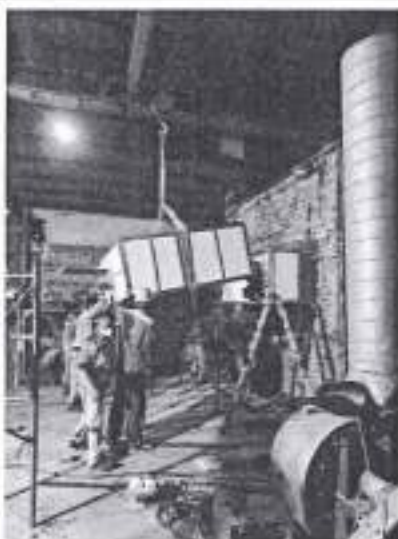
Nối đoạn ống có miệng hút
